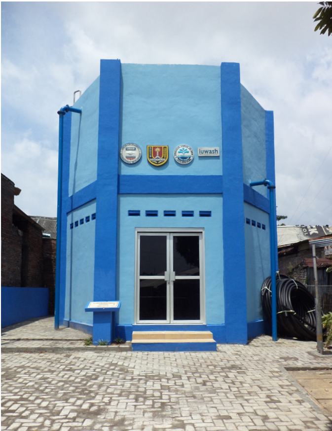
Penampung air (reservoir) baru berkapasitas 50 meter kubik yang dapat melayani kebutuhan air bersih bagi 1.000 kepala keluarga di Kelurahan Jomblang.
